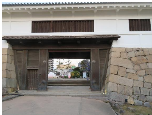
鉄板が打付けてある筋鉄御門(国の重文)
