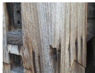
控柱下部の継手の技法
