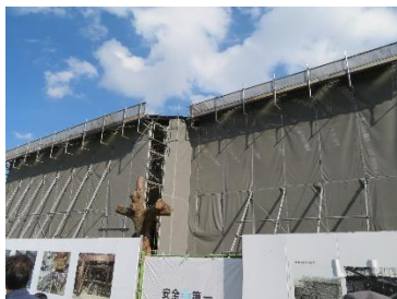
本丸御殿は改修中
