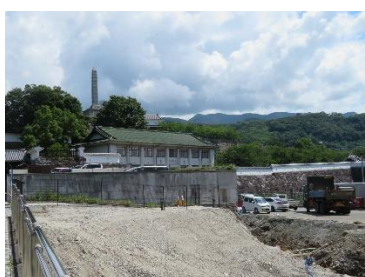
現在、濠の先端を工事中
