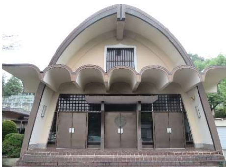
近代的な建物の本堂
