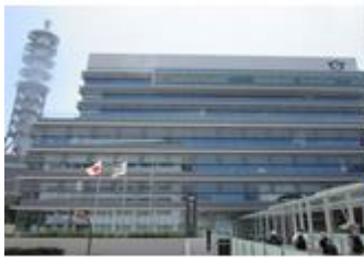
藤沢市役所・新庁舎
